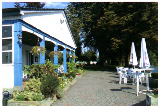
Die Anlage des RC Hamm
